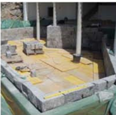
Mauern aus Tessiner Granit bilden die Basis des Natur-Pools.
